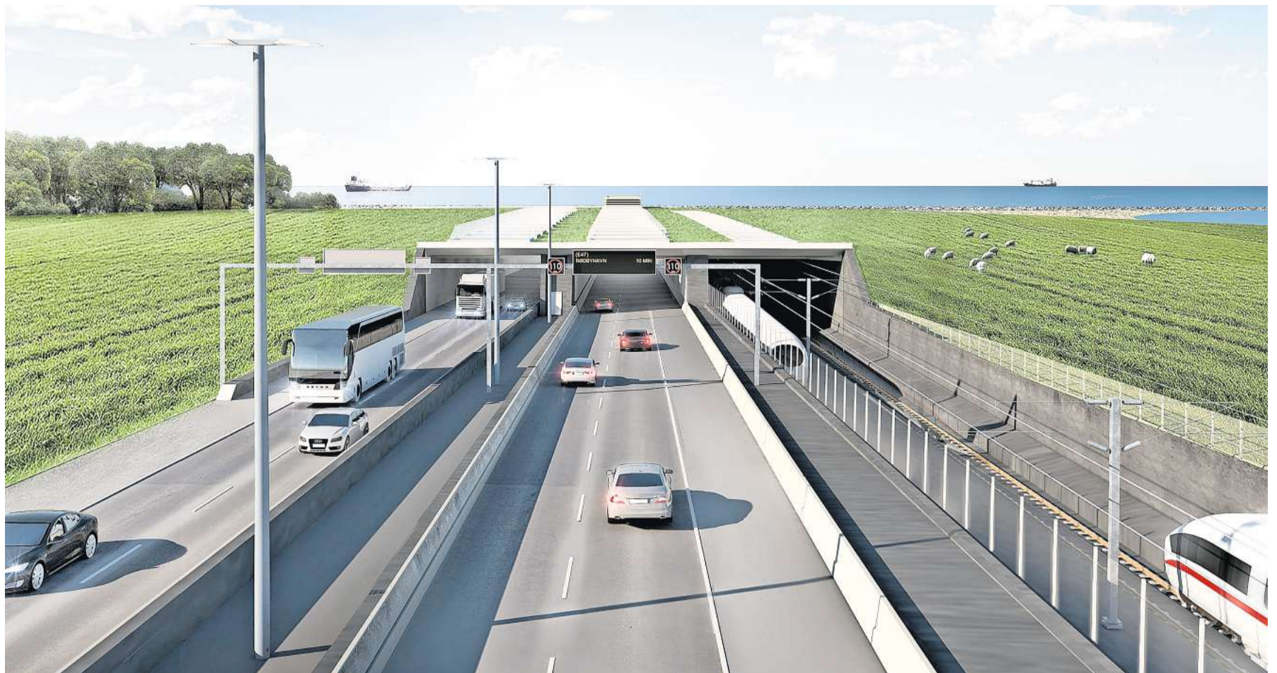
So sollen Züge und Autos in Richtung Fehmarn rollen. Die Visualisierung der dänischen Bauherren Femern A/S zeigt das Tunnelportal. Nach der Entscheidung des Oberverwaltungsgerichtes können die Bauarbeiten nun auch im Bereich des Fährhafens Puttgarden beginnen.
