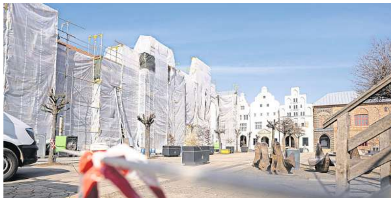
Die Fassaden der Häuser „Hanse in Europa“ werden im Hansa Park gerade erneuert. Noch stehen an einigen die Baugerüste.
