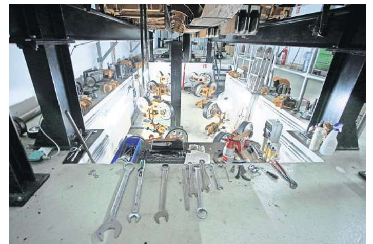
So sieht es im Winter in der Werkstattgrube unter dem „Abstellgleis“ der Achterbahn „Schwur des Kärnan“ aus.
