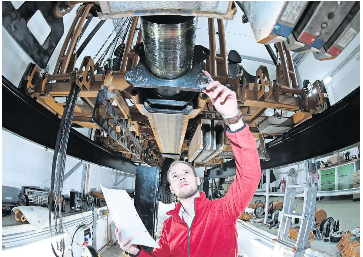
In der Winterpause wird jedes Einzelteil der Fahrgeschäfte im Hansa-Park unter die Lupe genommen. Werkstudent Till Schuhr prüft die Bolzen an einem der Wagen der Achterbahn „Schwur des Kärnan“.
