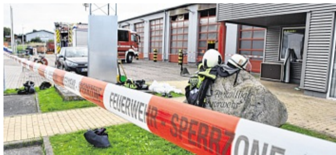
Die Fahrzeughalle der Oldenburger Feuerwehr ist nach dem Großbrand weiterhin gesperrt. Die Wehr kann jedoch wieder in den Einsatz starten. Foto: Alexander Steenbeck
