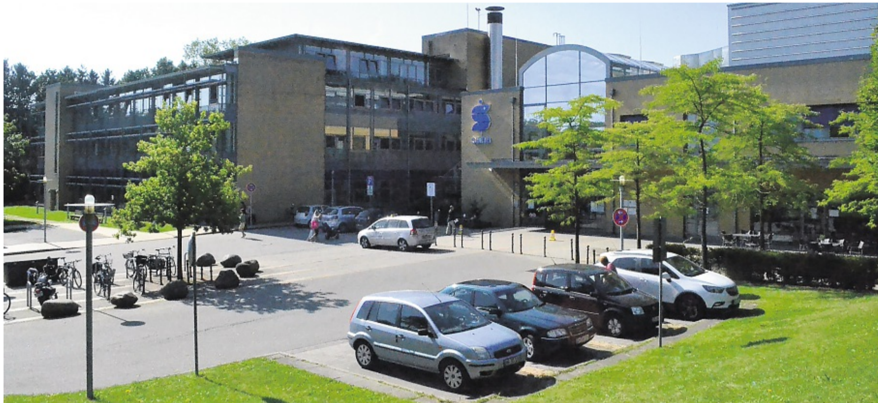
Vier Klinik-Standorte übernimmt Ameos von Sana, darunter auch das aufgrund völlig maroder Wasserleitungen stark sanierungsbedürftige Krankenhaus in Eutin. Foto: Schröder
